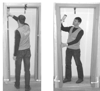
Bild 22: Einschäumen Stahlzarge
